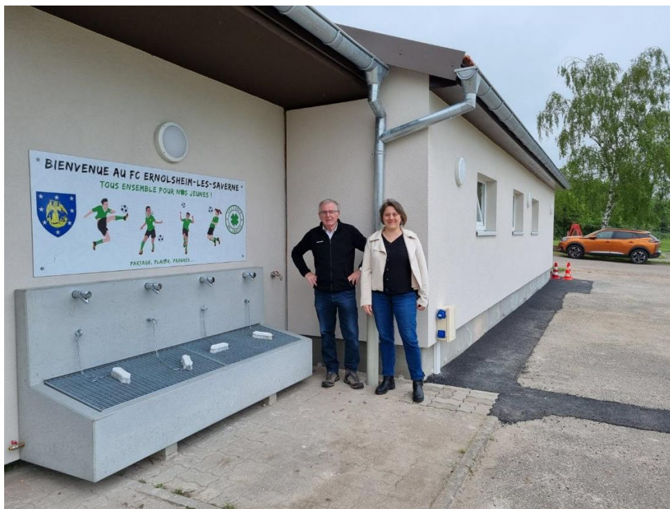
Les vestiaires du FC Ernolsheim-lès-Saverne ont été agrandis de 110 m 2 . Photo Simone Giedinger
